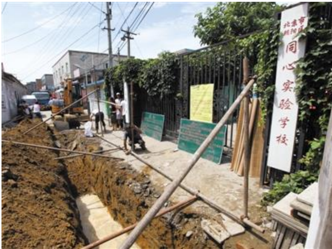
Photographie de 2011 : travaux devant l'école Tongxin
